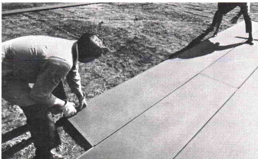
Sektionerna läggs lätt ut av två man på den planerade banan.
